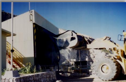
Tolva cubierta con caseta y sistema de Niebla Seca actuado automáticamente.
