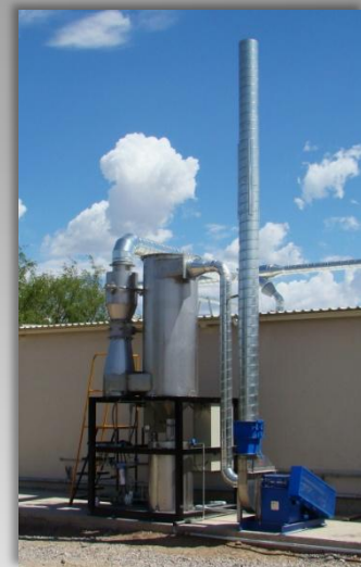
Lavador de Gases Venturi Variable, 2,500 acfm
